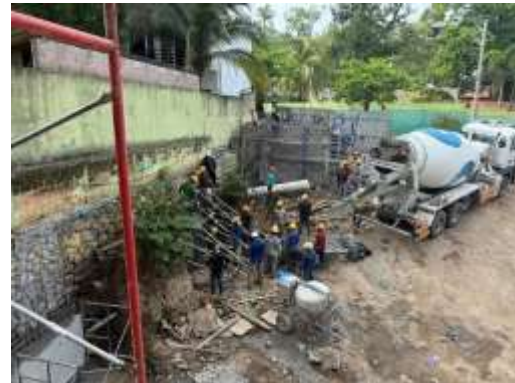
Colado de pantallas de muros
