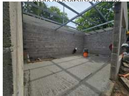
Colado de piso pulido en cuarto eléctrico
