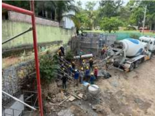
Colado de pantallas de muros de retención
