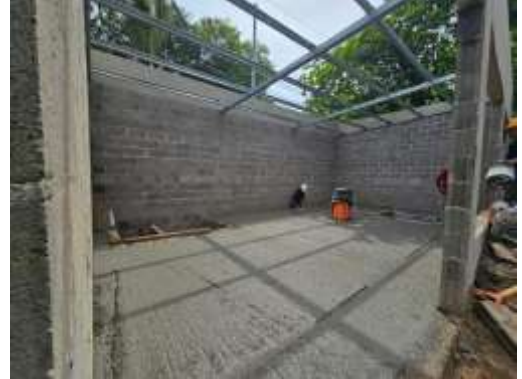
Colado de piso pulido en cuarto eléctrico
