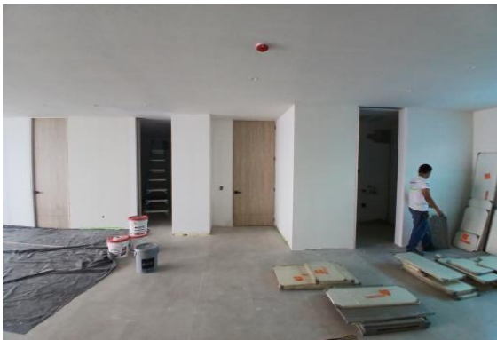
Instalación de puertas y armado de muebles en apartamentos
