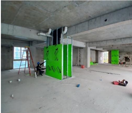
Forro de shafts nivel 6
