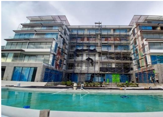
Cerramiento de vidrio total de fachadas
