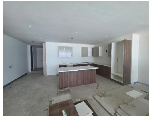
Avance de instalación de acabados y muebles en apartamentos
