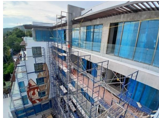
Instalación de pasamanos fachada sur
