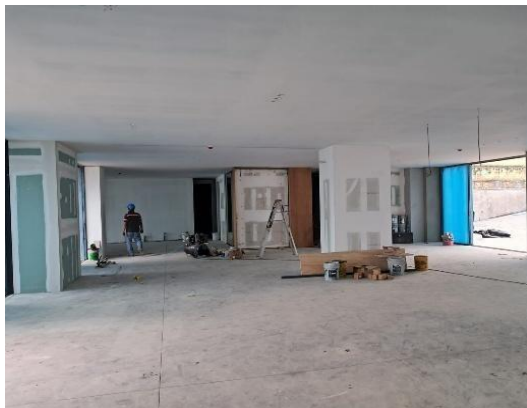
Avance en acabados en Lobby principal nivel 1
