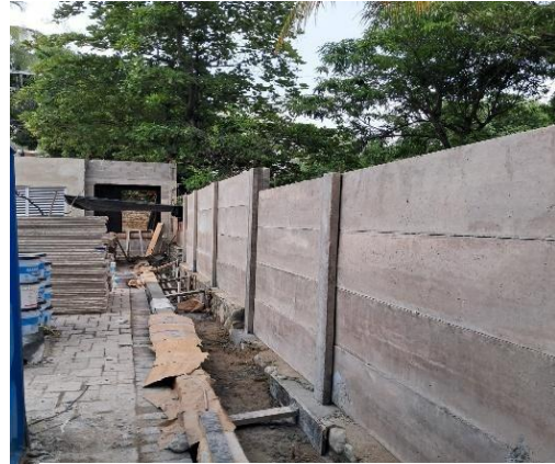
Avance de muro perimetral prefabricado
