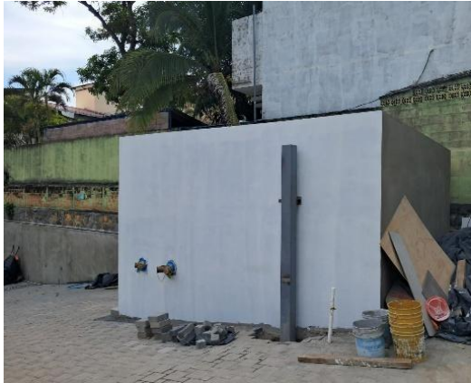
Finalización de cuarto de bombas
