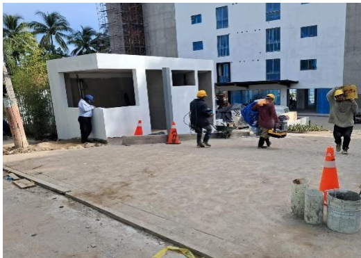
Avance de caseta de seguridad y avance en rampas de ingreso
