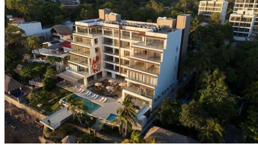
finalización de fachada sur y áreas de terrazas
