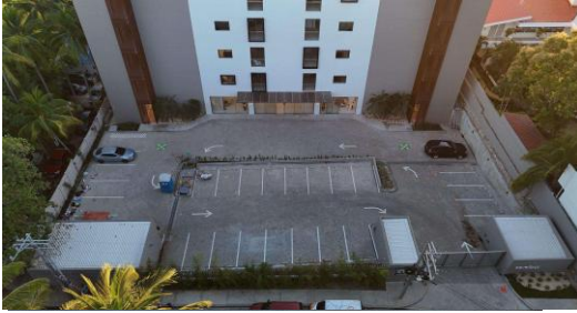
Finalización de parqueo y señalización
