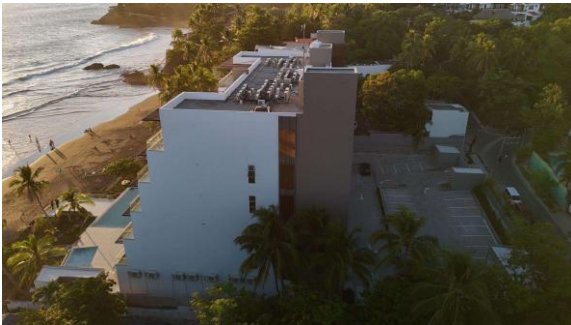
Finalización de pintura en fachada oriente
