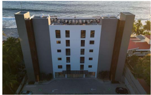
Finalización de fachada norte y azotea
