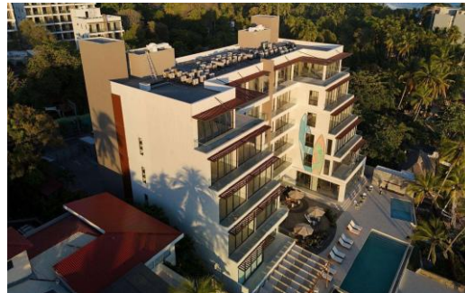
Finalización de pintura en fachada poniente.
