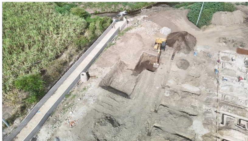
Avance de la PTAR.
