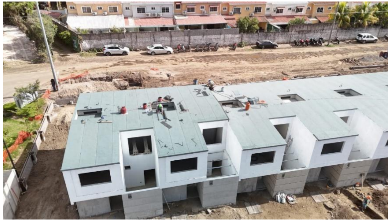
Avance de impermeabilización de losa.
