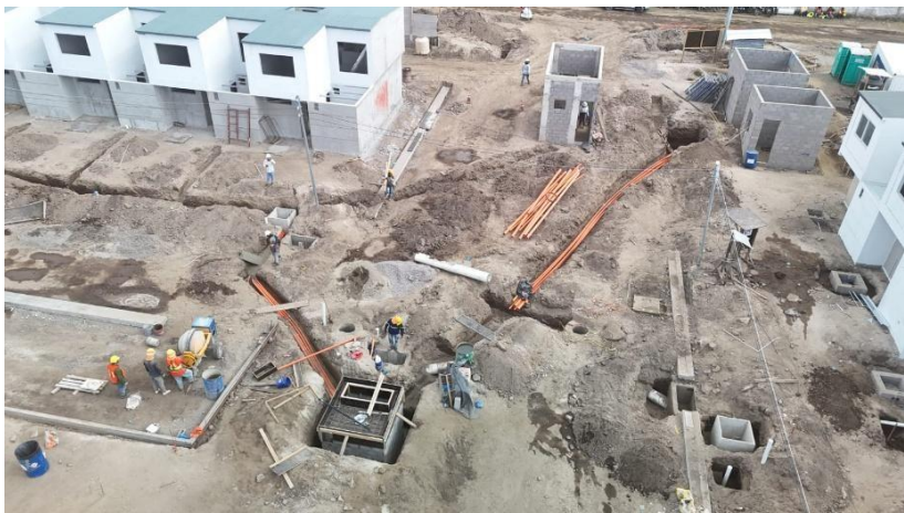
Avance de obra eléctrica
