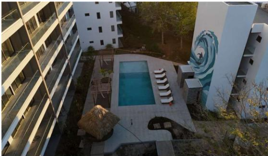
Acabados en área de piscina
