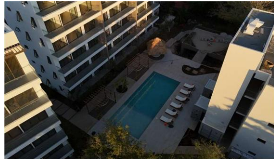
Acabados en área de piscina
