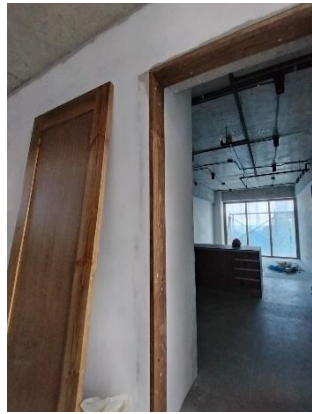
Instalación de puertas
