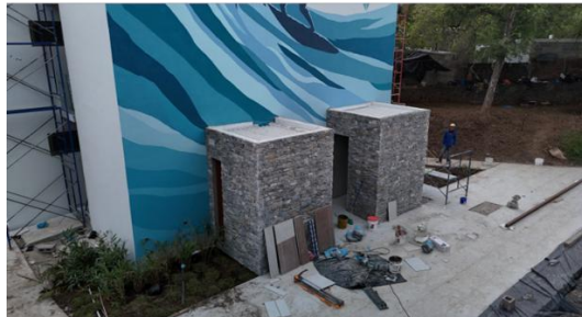
Acabados en área de piscina
