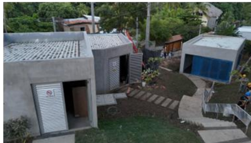
Zona de cuartos operativos y accesos
