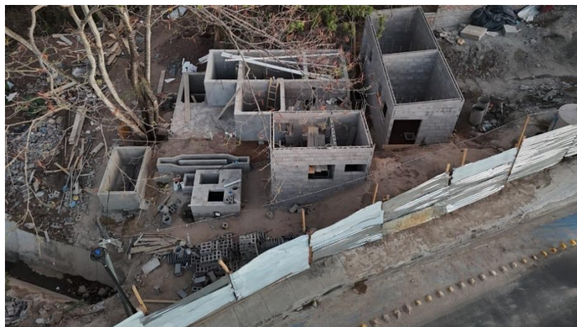
Avance obra PTAR
