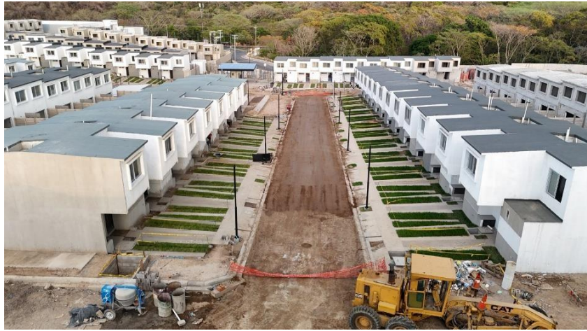
Avance de suelo cemento en el Grupo 1.
