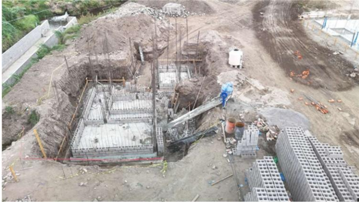
Avance obra PTAR
