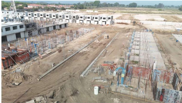
Avance cordones en el Grupo 5
