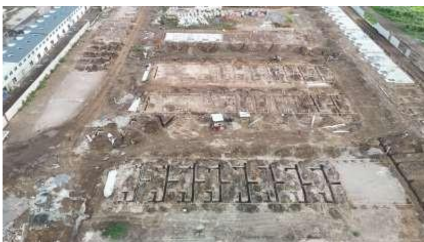
Avance en fundaciones de clúster 3
