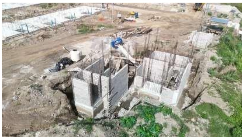
Avance obra PTAR
