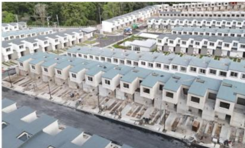
Impermeabilización de techos
