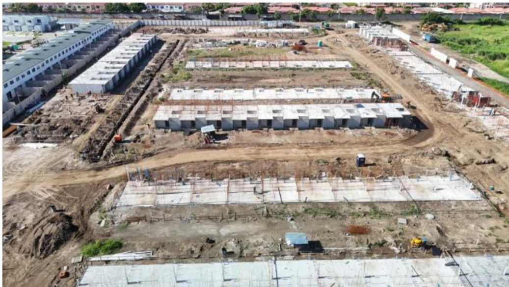
Avance en colados de primer nivel de clúster 3
