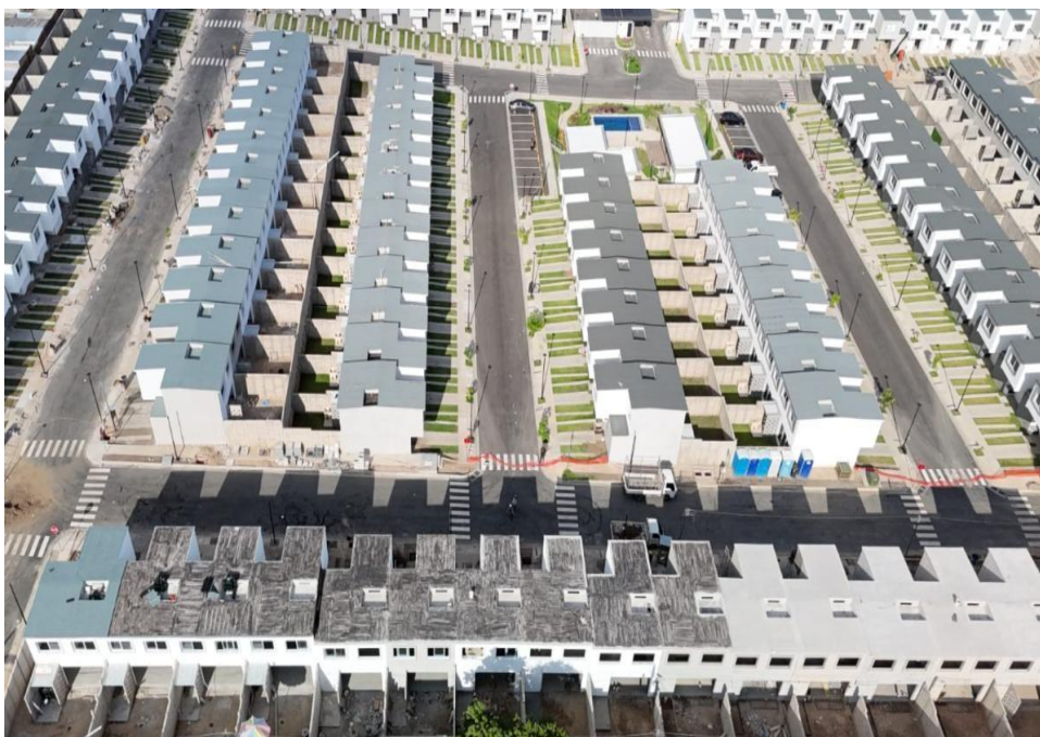
Impermeabilización de techos
